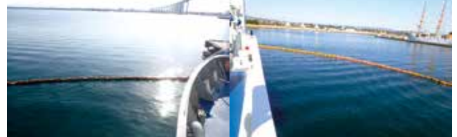
オイルフェンス展張作業
